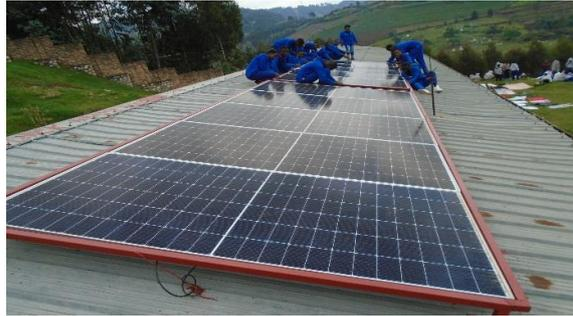
Handwerk, das den Stahlrahmen für die Paneele herstellte und installierte, und das Elektrohandwerk, das die Verkabelung und Anschlüsse vornahm. Seit Abschluss dieses Projektes stammen 85 % des Verbrauchstroms der Schule aus der Photovoltaikanlage. Insbesondere der Computerraum, der Mädchenschlafsaal und die Mensa haben davon profitiert.
